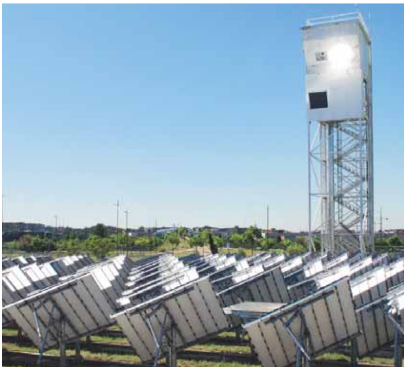
Demonstrations-Anlage zur Erzeugung von solaren Kraftstoffen im Projekt SUN-to-LIQUID.
